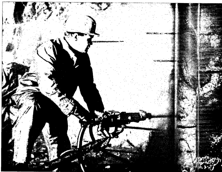
62 Reciente construcción del metropolitano y muestras del suelo rocoso de la zona urbana.
