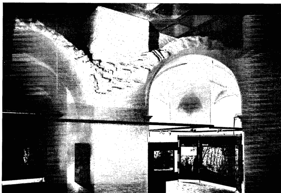
13 Sala de la torre noroeste. Los voladizos han sido reconstruidos. En la parte delantera donde fue destruida la bóveda se ha construido un techo en hormigón con encofrado de tipo cajón.
