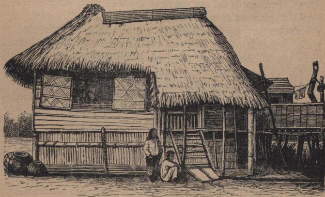
CABAÑA CONSTRUIDA CON BAMBÚ.
