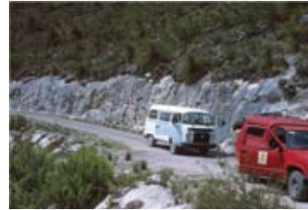
Construcción de caminos.
