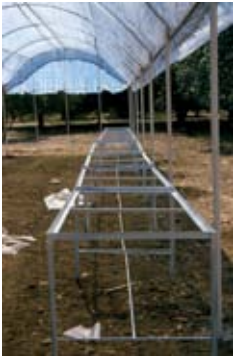
Construcción de mesas.
