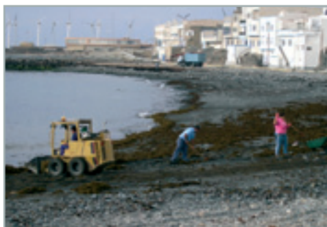
Foto 29 Retirada del arribazón de algas de la playita que se encuentra al abrigo de ambos muelles frente al pueblo de Pozo Izquierdo con la ayuda de una minicargadora. Al fondo se puede observar el camión grúa con el sistema de agarre pulpo retirando los arribazones de algas de la zona de callaos .
