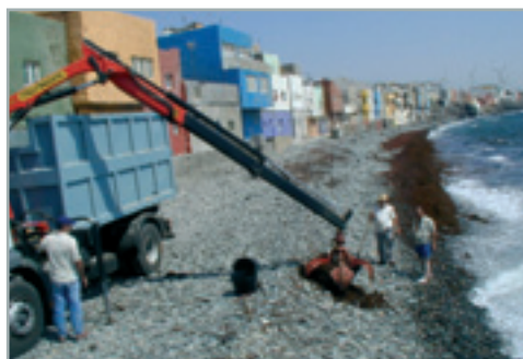
Foto 28 Izada del arribazón de algas apilado en la zona de callaos frente a la Avenida de Las Gaviotas en Pozo Izquierdo mediante una grúa con el sistema de agarre pulpo.
