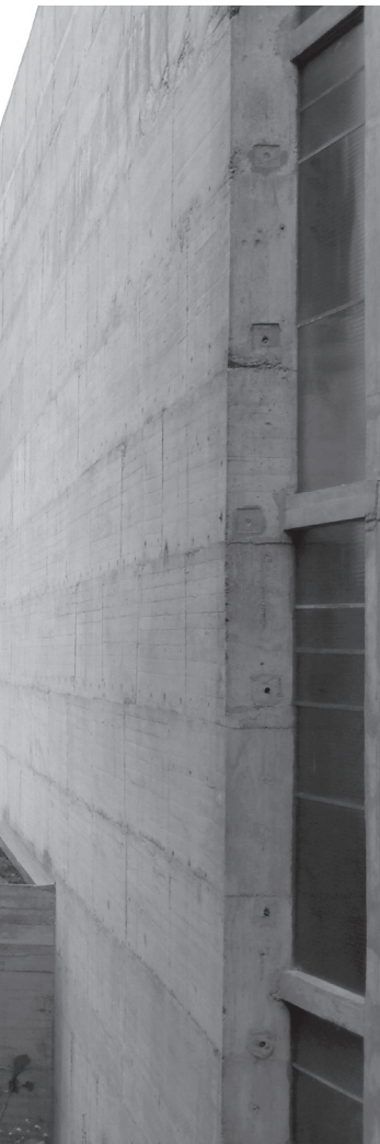
04 Convento de Sainte Marie de la Tourette, Eveux-sur-l'Arbresle, Francia, vista de la volumetría en el espacio central
