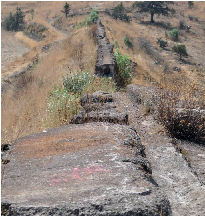
Figura 11. Caño quebrado, Tetzcotzinco. Fotografía tomada en 2017.
