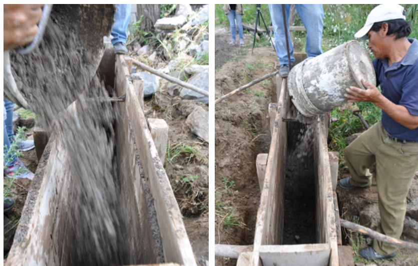
▲ Vaciado de la mezcla en el molde alternando el sentido. Tepeyahualco, Puebla. LABPYSCT. Septiembre de 2015. Crédito: Ángeles Vizcarra de los Reyes.
