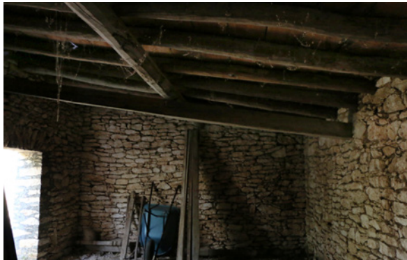
▲ Vista interior donde se puede ver el entramado de tres niveles de vigas. LABPysCT. Noviembre de 2014.
