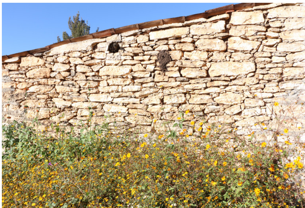
▲ Vista de la fachada lateral en que se aprecia la coronación del muro. LABPYSCT. Noviembre de 2014. Crédito: Tatiana Santoyo Albo.
