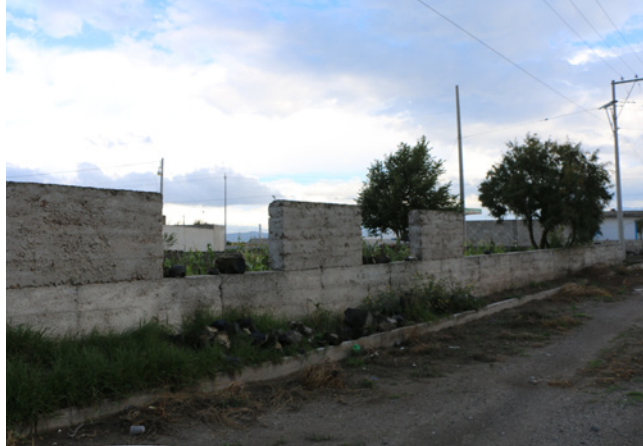
▲ Alternancia en la construcción de bloques de tapia para permitir el secado. Tepeyahualco, Puebla. LABPYSCT. Agosto de 2016. Crédito: Ángeles Vizcarra de los Reyes.
