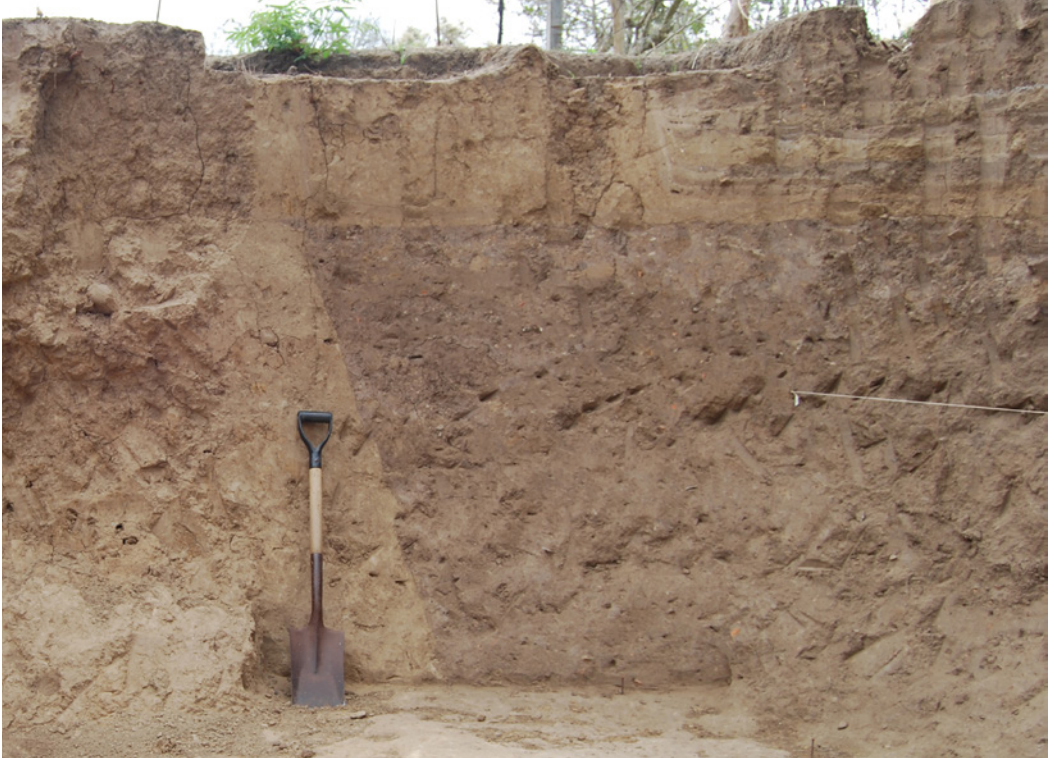
▲ Documentación del empleo de compartimentos o celdas conformadas con rellenos alternados de diferentes tipos y colores de tierra que sirven para dar mayor estabilidad en la compactación. La Joya, Veracruz. 2010. Crédito: Luis Fernando Guerrero Baca.
