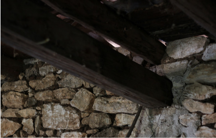
▲ Detalle de mezcla, casilleros y piedras de cadenamamiento. LABPYSCT. Noviembre de 2014. Crédito: Tatiana Santoyo Albo.
