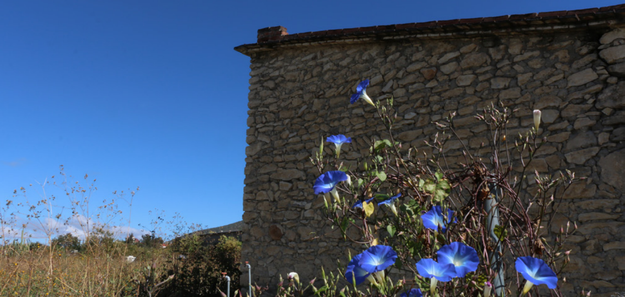
▲ Casa de piedra caliza de Santo Tomás Tamazulapan, Oaxaca. LABPYSCT. Noviembre de 2014. Crédito: Axayácatl Sánchez Sámano.
