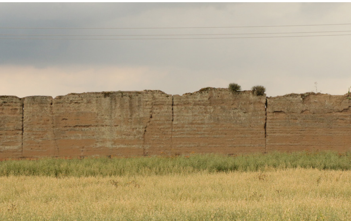
▲ Tapias fabricadas con pies derechos y tablonés en la ex hacienda de Mazapa, Tlaxcala. Estas tapias llegan a tener dimensiones de 5 m de largo y 3 m de altura. LABPYSCT. Octubre de 2018. Crédito: Arieth Vega Huerta.
