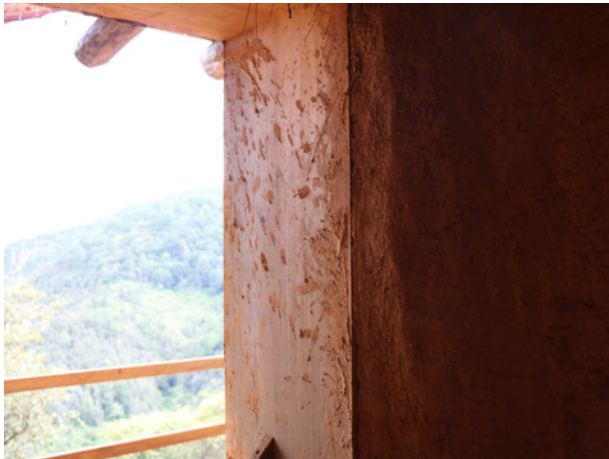
◀ Construcción de tierra anegada y paisaje. LABPYSCT. Noviembre de 2014. Axayácatl Sánchez Sámano.
