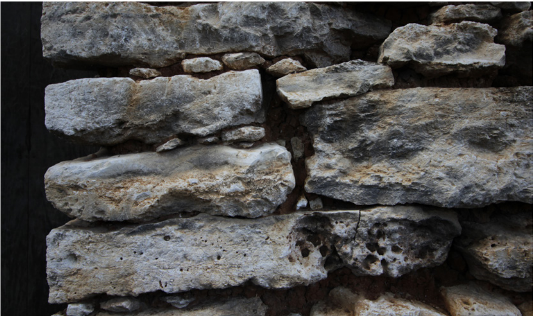
▲ Detalle de muro con ripios para ajustar la colocación. LABPYSCT. Noviembre de 2014. Crédito: Jessica G. López Hernández.
