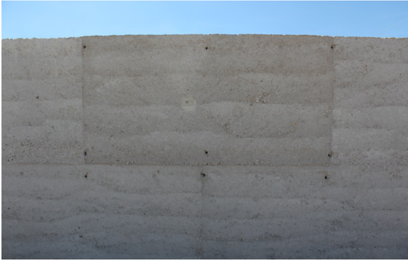
▲ Contrapeo con piezas alternadas a la mitad para evitar la junta constructiva continua, como en cualquier tipo de mampostería. Tepeyahualco, Puebla. Diciembre de 2018. Crédito: Ángeles Vizcarra de los Reyes.
