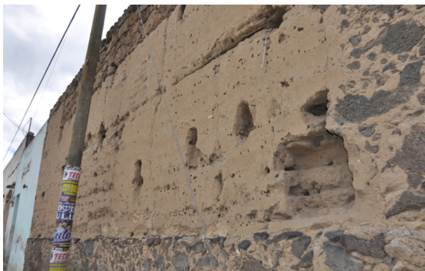
▲ Tapia con cimiento de piedra y rodapié. San Andrés Payuca, Puebla. LABPYSCT. Agosto de 2018. Crédito: Ángeles Vizcarra de los Reyes.
