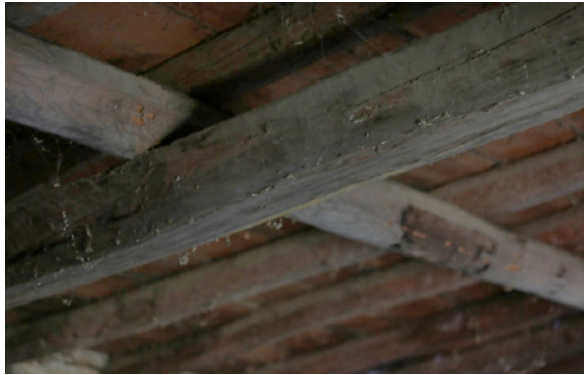
▲ Detalle de empotre simple de vigas de cubierta. LABPysCT. Noviembre de 2014. Crédito: Jessica G. López Hernández.
