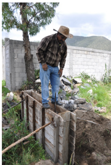
▲ Encofrado usado en la región. Tepeyahualco, Puebla. LABPysCT. Septiembre de 2015. Crédito: Ángeles Vizcarra de los Reyes.
