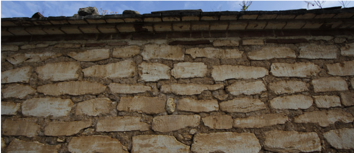
▲ Detalle de enrase de muro. LABPysCT. Noviembre de 2014. Crédito: Tatiana Santoyo Albo.
