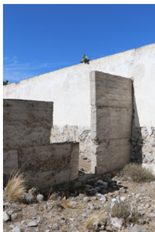
▲ En esta imagen se aprecia el espesor de una tapia de poma. Exhacienda Pizarro, Tepeyahualco, Puebla. LABPYSCT. Diciembre de 2014. Crédito: Ángeles Vizcarra de los Reyes.
