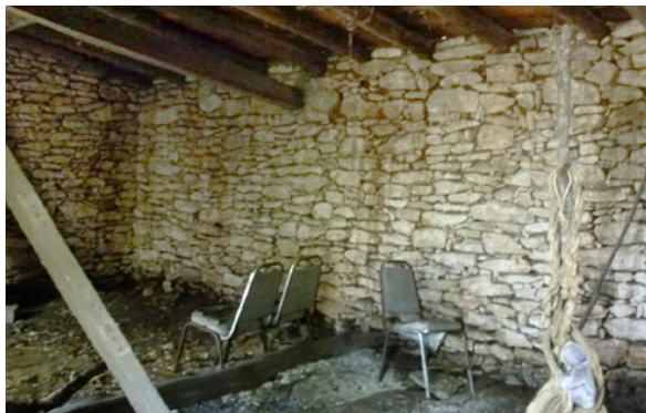
▲ Vista interior donde se aprecia la llegada de morillos a muro posterior. LABPysCT. Noviembre de 2014. Crédito: Jessica G. López Hernández.
