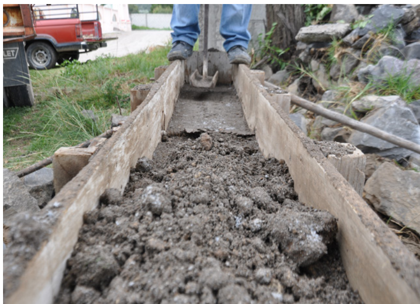
▲ Apisonamiento de la tapia. Tepeyahualco, Puebla. LABPYSCT. Septiembre de 2015. Crédito: Ángeles Vizcarra de los Reyes.
