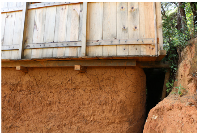
▲ Desplante de casa en terreno en pendiente. LABPysCT. Noviembre de 2014.
