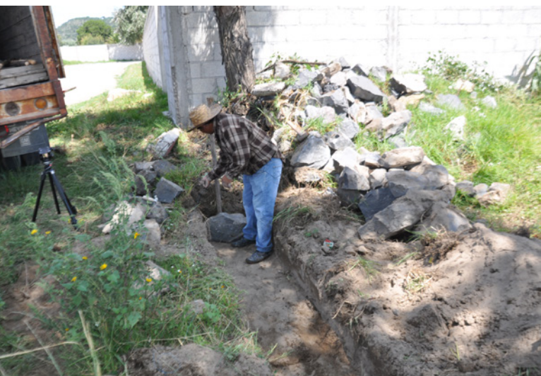
▲ Excavación de cimentación y tendido de piedra volcánica. Tepeyahualco, Puebla. LABPysCT. Septiembre de 2015. Crédito: Ángeles Vizcarra de los Reyes.
