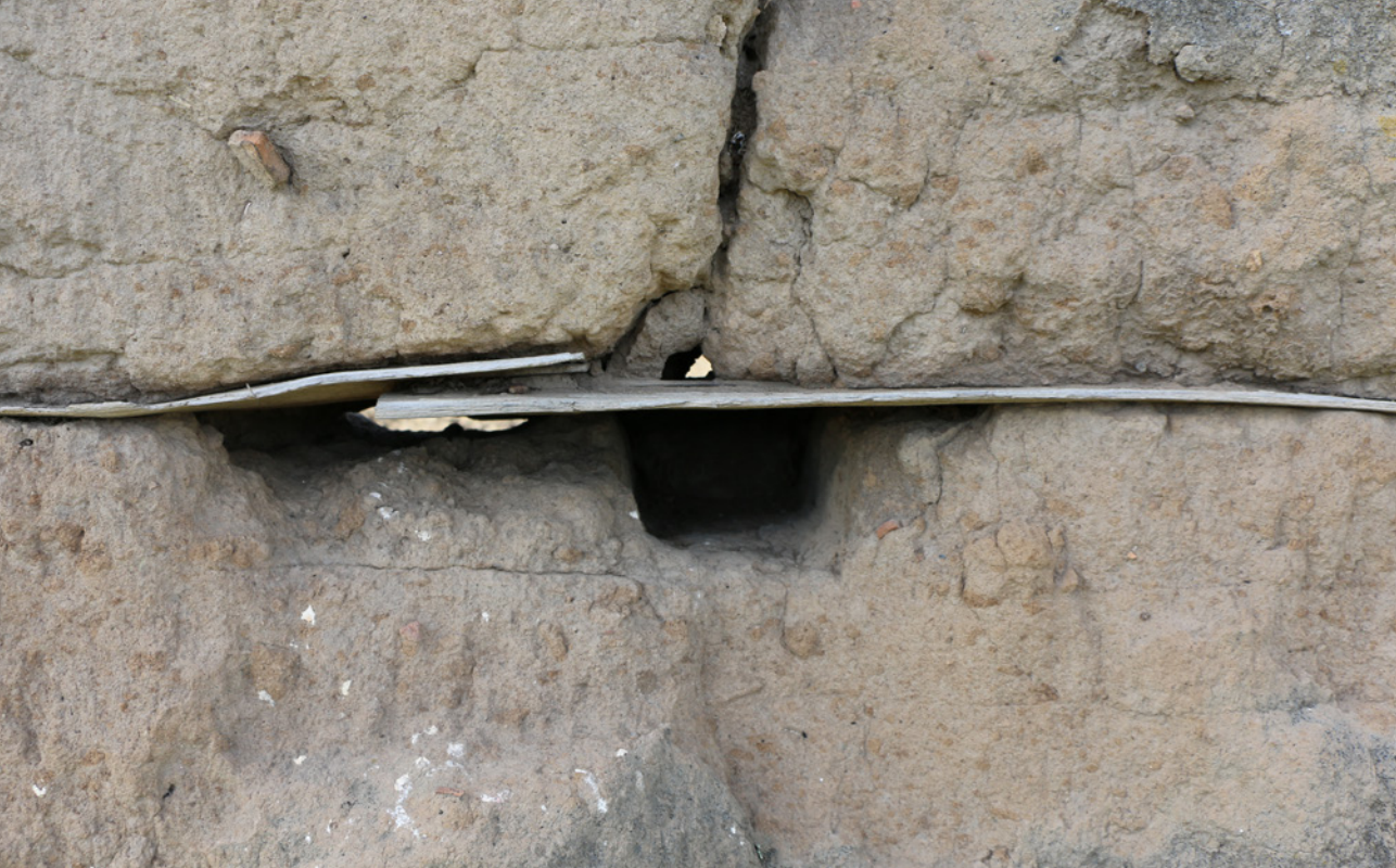
▲ Ejemplo de la madera utilizada para reforzar la unión entre tapias, en la ex-hacienda de Mazapa, Tlaxcala. LABPYSCT. Diciembre de 2018. Crédito: Esaú Gallegos Sánchez.
