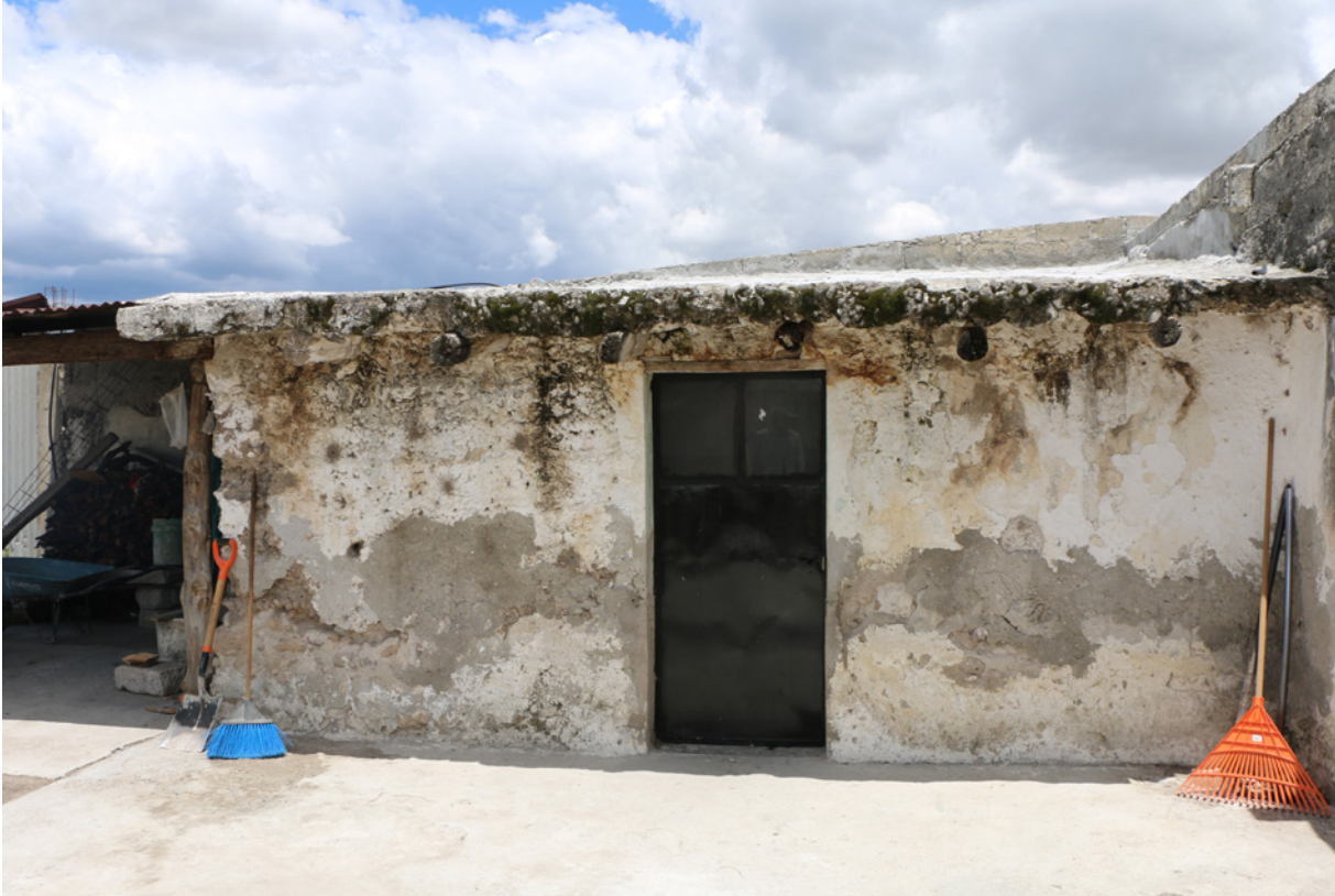
▲ Techo de morillos y entortado de cal y piedra poma de vivienda popular en El Fuerte de la Unión. Tepeyahualco, Puebla. LABPYSCT. Agosto de 2016. Crédito: Diego Andrés García Ruíz.
