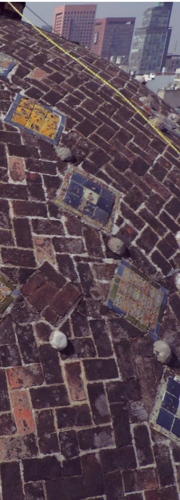
La gran cúpula, una estructura semiesférica de mampostería de tezontle sobre un tambor cilíndrico con ventanería, de 14.79 metros de diámetro y 5.56 metros de altura, presentaba agrietamientos importantes y se encontraba inclinada hacia el sur-poniente sobre su eje original. Su principal problema era la compresión de la cúpula sobre la base, lo que provocaba filtraciones de agua.
