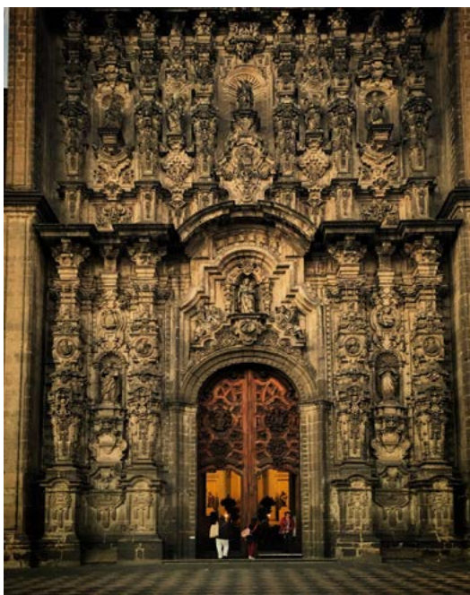
Imagen 23. La durabilidad de los materiales al desgaste seguirá siendo uno de los ejes rectores en el diseño del entorno. Cuanto más dure un edificio, menor será su huella ecológica. Fachada principal del Sagrario Metropolitano, construida en piedra chiluca. Ciudad de México. Fuente: Imagen del autor.
