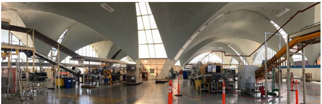
Imagen 19. Los paraboloides hiperbólicos de concreto armado de Félix Candela comunican un concepto de alta eficiencia: máxima superficie construida utilizando el mínimo de apoyos y el mínimo de material, en este caso, el concreto armado. Planta de Bacardí, Estado de México. Fuente: Imagen del autor.
