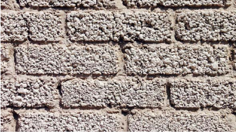
Imagen 31. Tabiques de cemento-arena en un muro. Imagen del autor.
