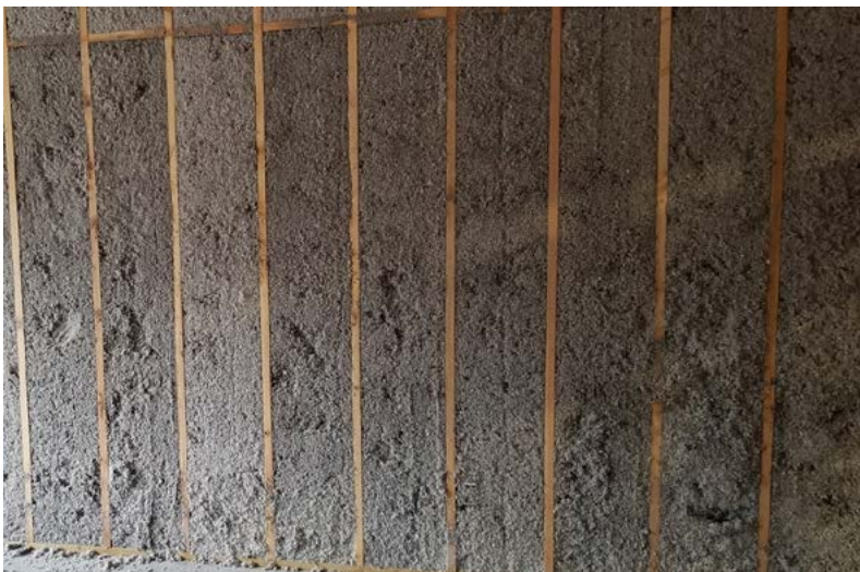
Imagen 45. Aislamiento térmico con fibras de celulosa proyectada. Imagen Creative Commons.
