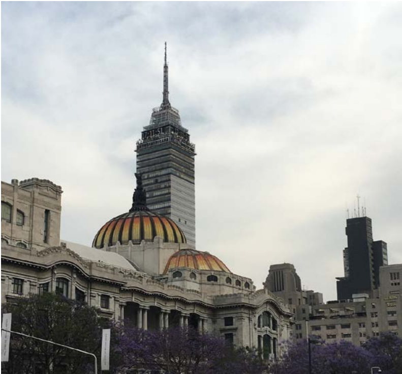
Imagen 39. El cobre se utilizaba como impermeabilizante metálico, esta técnica se encuentra en desuso. Las cúpulas del Monumento a la Revolución o el Palacio de Bellas Artes cuentan con este sistema en sus cubiertas. Fuente: Imagen del autor.
