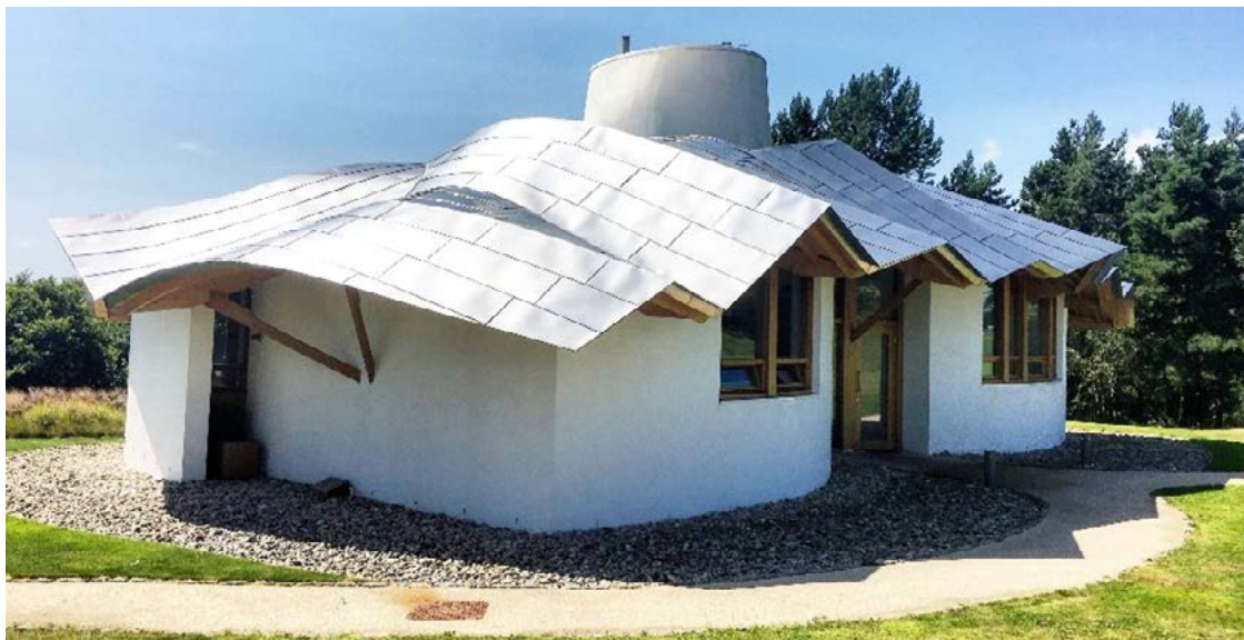
Imagen 22. La edificación del futuro tenderá a reutilizar técnicas en desuso el día de hoy, utilizando los mismos materiales. Edificio que utiliza un sistema impermeabilizante metálico en su cubierta combinando metal y vigas de madera laminadas en su interior. Maggie's Centre Dundee. Reino Unido. Fuente: Imagen del autor.
