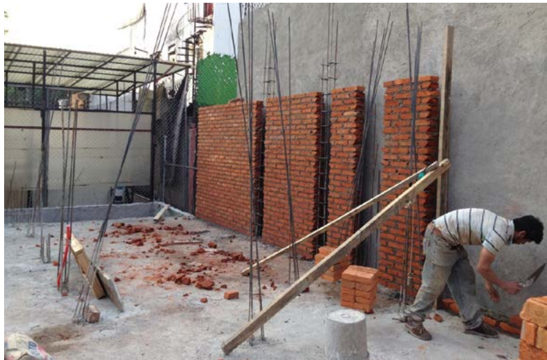
Imagen 8. Proceso constructivo de muros de mampostería confinada previo al cimbrado y colado de los castillos. Ciudad de México. Imagen del autor.
