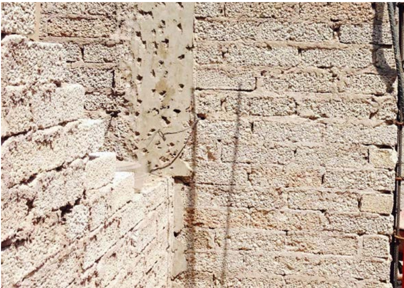
Imagen 10. Tabiques de cemento-arena en una obra de autoconstrucción. Ecatepec, Estado de México. Imagen del autor.
