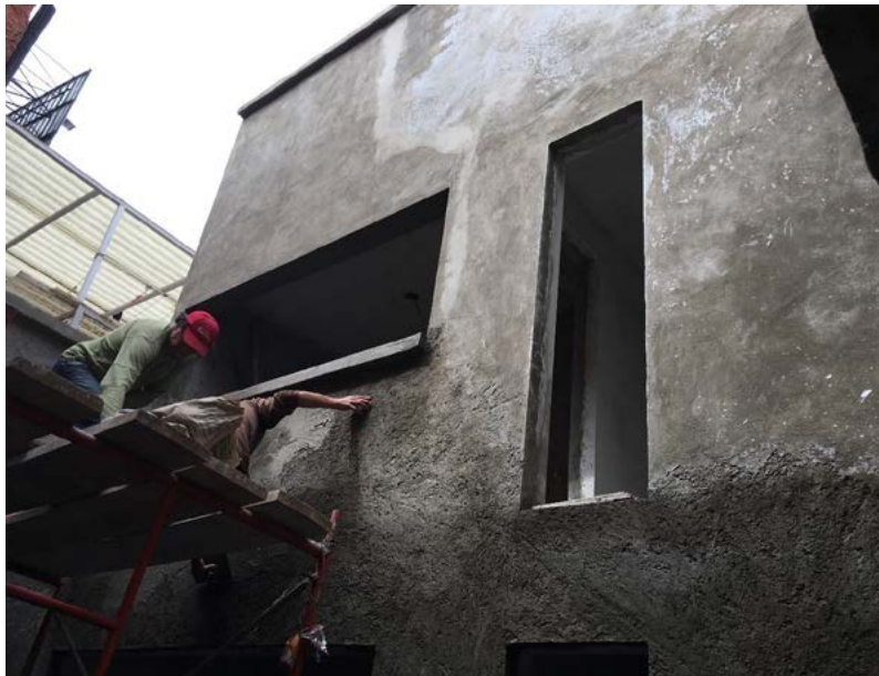
Imagen 11. Muro de tabique rojo recocado siendo aplanado en su exterior con una capa de mortero de cemento-arena. Ciudad de México. Imagen del autor.
