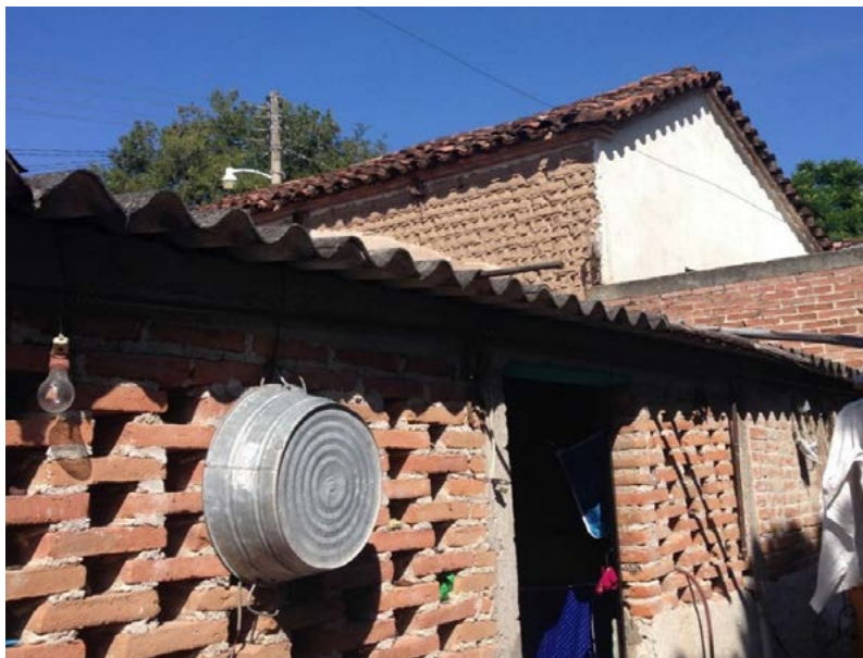
Imagen 3. Casa que modera la entrada de energía solar a través de una celosía y un techo entretejido de carrizos, madera y barro. Guerrero, México. Imagen del autor.
