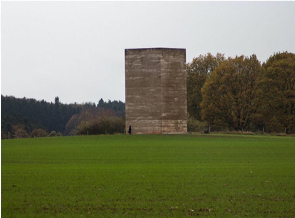
Fotografía de la Bruder Klaus Feldkapelle de Peter Zumthor. Juan Carlos Calanchini González Cos, 2017.
