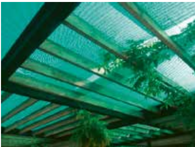
FIG: Techumbre del patio. Fuente: Elaboración propia.
