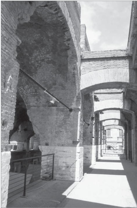
Figs. 91, 92 y 93. MERCADO DE TRAJANO (Foro Imperial de Trajano, Roma, Siglo II). Arriba. Tramos de bóvedas de arista romanas. Abajo izquierda. «arbotantes» exteriores de estriado de los empujes de las bóvedas de arista de la figura anterior, reconstruidos. Abajo derecha. SANTA MARÍA DE LOS ÁNGELES - TERMAS DE DIOCLECIANO (Roma, siglos II-XVI). Tramos de bóvedas de arista romanas, restauradas por Miguel Ángel. Ver las ventanas en los vanos laterales, abiertos ya en época romana.
