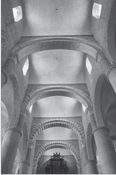
Figs. 83, 84 y 85. Arriba izquierda. SANT PHILIBERT DE TOURNUS (Francia, siglo XI-XII). Bóvedas de la nave central de la iglesia, de eje transversal a la nave. Arriba derecha. Capilla de San Miguel. Detalle de los «arcos concéntricos» de la plementería de una bóveda de cuarto de esfera de un tramo de la nave lateral norte, hacia la nave central. Abajo. ABACIAL CISTERCIENSE DE FONTENAY (Francia, siglo XII). Vista hacia los pies de la iglesia. Ver las bóvedas de medio cañón transversales al eje de la nave central, con el autor de este texto más joven.
