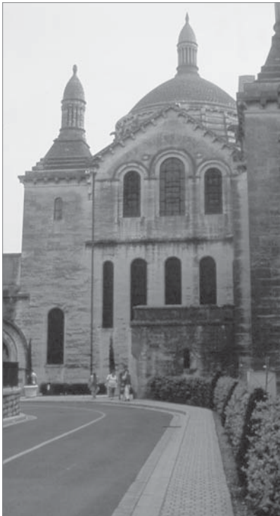
Figs. 137, 138 y 139. Arriba. CATEDRAL DE ANGOULÊME (Francia, siglos XI-XII). Notable cúpula sobre cimborrio con amplias ventanas. Ver en la base del casquete un murete de sillería con contrafuertes. Abajo izquierda. SAINT FRONT DE PERIGUEUX (Francia, siglos XI-XIX). Ver el anillo de fábrica que se eleva hasta la mitad del casquete para estribar mejor sus empujes y tracciones. Abajo derecha. TORRE DE SANTA MARÍA DE AÍNSA (Huesca, siglo XII). Cúpula de gajos octogonales sobre trompas. Ver los arcos adosados en el centro del intradós de los gajos octogonales.
