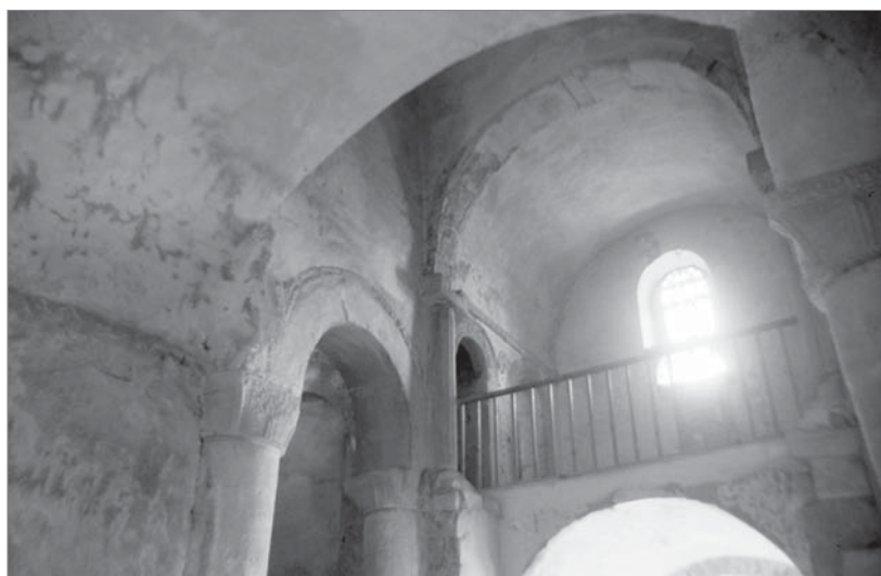
Figs. 263, 264 y 265. Arriba izquierda. SANTA MARÍA DEL NARANCO (Oviedo, España, hacia 848). Interior de la noble planta alta, con su bóveda de medio cañón sobre arcos fajones apilastrados en semicolumnas que se corresponden perfectamente con los contrafuertes exteriores. Arriba derecha. Ver los contrafuertes exteriores y la magnífica tribuna. Abajo. SAN MIGUEL DE LILLO (Oviedo, España, 842-850). Vista de la tribuna sobre el atrio, desde la nave.
