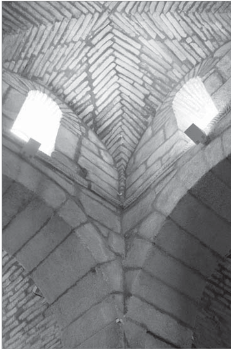
Figs. 246, 247 y 248. Arriba. ABACIAL DE ALAÓN (Huesca, España, siglo XII). Ver cómo todos los arcos concurrentes en el plano de imposta del pilar cruciforme presentan salmeres independientes. Abajo izquierda. SANTA COMBA DE BANDE (Orense, España, siglo VII). Iglesia hispano visigótica. Entrega de los arcos torales del crucero con claros salmeres compartidos. Abajo derecha. SAN CLEMENTE DE BRESCIA (Italia, siglo VIII). Salmeres compartidos en la arquería sur de la nave central.
