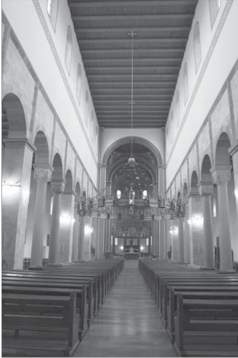
Figs. 211, 212 y 213. Arriba. SAN GOTARDO (Hildesheim, Alemania, siglo XII). Iglesia que sigue la conformación de la basílica paleocristiana, ya en el siglo XII. Ver cómo las arquerías de su nave central se estriban en columnas alternadas con pilares de sección cuadrada que las estabilizan. Ver el cielo raso de madera que oculta los sistemas de armaduras de su cubierta en la nave central. Abajo izquierda. SAN JUAN DE LA PEÑA (Huesca, España, siglo XI). Pilar cruciforme de la Sala de los Concilios. Abajo derecha. IGLESIA TIPO. SECCIÓN TRANSVERSAL Y TRAMO DE LA PLANTA. Pilares cruciformes, pilastras de sección recta, sin contrafuertes.
