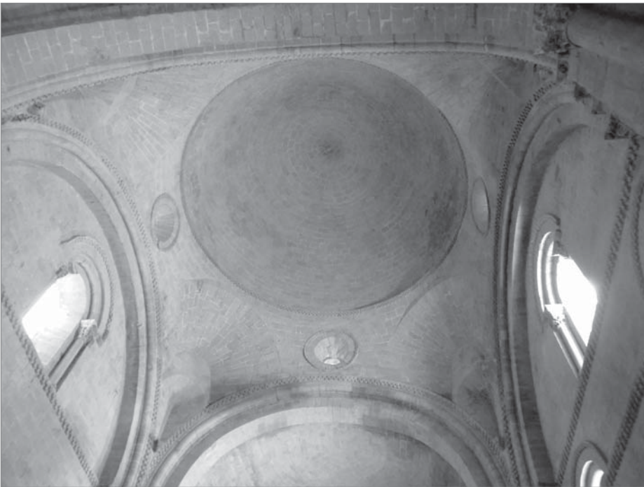
Figs. 126 y 127. Arriba. SAN CATALDO (Palermo, Sicilia, siglo XII). Cúpulas fuertemente peraltadas y exentas. Abajo. IGLESIA DE SAN PEDRO EN EL CASTILLO DE LOARRE (Huesca, siglo XI). Cúpula con casquete sobre un sistema compuesto de trompas.
