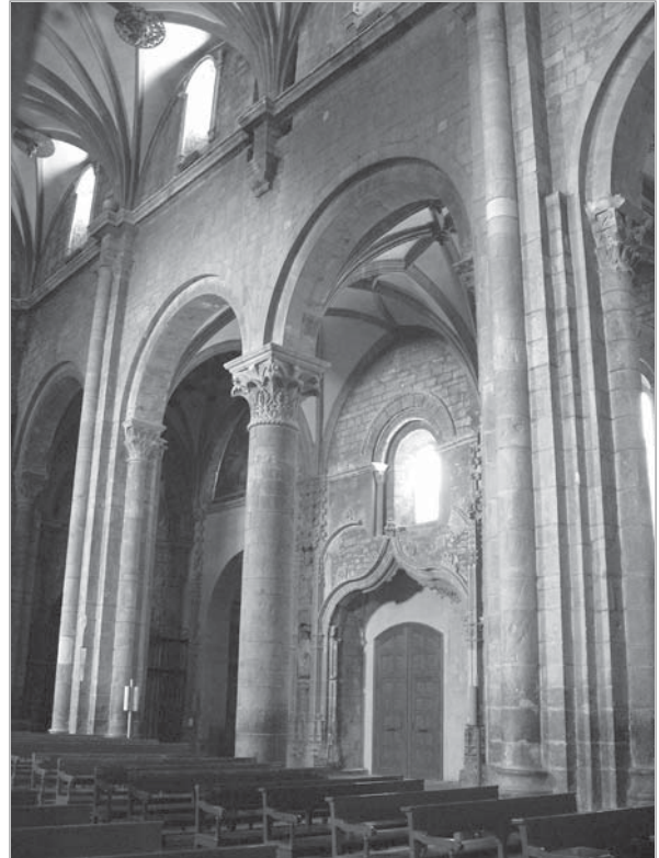
Figs. 226, 227 y 228. Arriba izquierda. MONASTERIO DE SAN JUAN DE LA PEÑA. IGLESIA BAJA (Huesca, España, siglo XI). Columna de tambores, en la arquería que divide las naves. Ver el salmer compartido. Arriba derecha. SANT'ABBONDIO DE COMO (Italia, siglo XI). Columnas estribando las arquerías de la nave central. La nave, de tipología basilical está cubierta por armaduras de madera, y es posterior a la obra lombarda del primer tercio del siglo XI. Abajo. CATEDRAL DE SAN PEDRO DE JACA (Huesca, España, siglo XI). Columna construida con tambores elaborados con piezas aparejadas, entre dos pilares compuestos, conformando un tramo doble.
