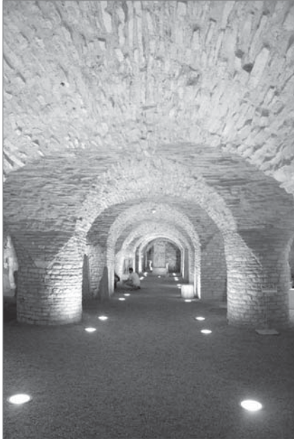
Figs. 94, 95 y 96. Arriba. BASÍLICA DE MAJENCIO-CONSTANTINO (Foro Republicano, Roma, siglo IV). Ver los sistemas de contrafuertes-arquitos aún conservados, dispuestos para estribar las potentes bóvedas de arista de argamasa y arcos de ladrillo embutido que existieron en la nave central. Abajo izquierda. BODEGA DEL ACTUAL MUSEO DE SAINT BENIGNE DE DIJÓN (Francia, inicios del siglo XI). Sus tres naves están cubiertas por bóvedas de arista continuas de tipología romana, sin arcos. Nave central. Abajo derecha. ROTONDA DE GUILLERMO DE VOLPIANO. SAINT BENIGNE DE DIJÓN (Francia, siglo XI). Sólo nos llega una pequeña parte de la gran cripta y la primera planta de las tres que tuvo la rotonda. Deambulatorio exterior. Ver cómo se cubre con tramos alternados de bóveda de medio cañón con lunetos y bóveda de arista románica de tipología romana, con arcos fajones. Estos arcos son de tipología lombarda y además empotran sus arranques en la bóveda.
