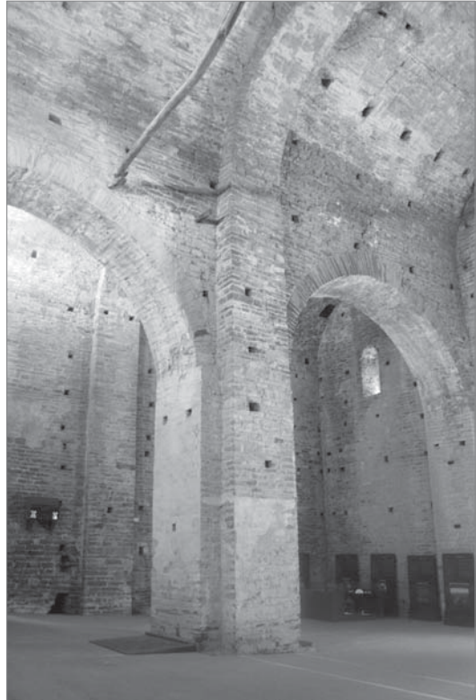
Figs. 6, 7 y 8. Arriba izquierda. RUEDA DE ELEVACIÓN MEDIEVAL. Se conserva restaurada en la Abadía de Saint Michel. (Normandía. Francia). Arriba derecha. ANDAMIO TIPO PARA LA CONSTRUCCIÓN DE UN MURO. Abajo. SAN PEDRO DE CASERRES (consagrada en 1053, Gerona, España). Vista parcial desde la nave central hacia los pies. Ver el importante número de mechinales en sus fábricas y el masivo pilar cruciforme del que se tratará más adelante.
