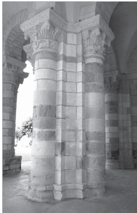
Figs. 217, 218 y 219. Arriba izquierda. PANTEÓN DE LOS REYES, SAN ISIDORO DE LEÓN (primer tercio del siglo XI). Pilar de núcleo cruciforme con semicolumnas en sus cuatro caras Arriba derecha. CATEDRAL DE SPEYER (Francia, siglo XI). Pilar cruciforme con semicolumnas sólo en correspondencia con los arcos fajones. Ver cómo la semicolumna de la nave central se articula en dos mediante la introducción de un capitel, adelgazándose además el tramo superior. Abajo. FLEURY, SAN BENOIT SUR LOIRE. PÓRTICO OCCIDENTAL (Francia, siglo XII). Pilar cruciforme, muy restaurado por sustitución y retejido de sus sillares, con núcleo cruciforme, que presenta sus ángulos achaflanados y pilastras con semicolumnas en sus cuatro caras. Ver cómo el importante ábaco se dispone en transición de la irregular planta del núcleo para recibir arcos y aristones.
