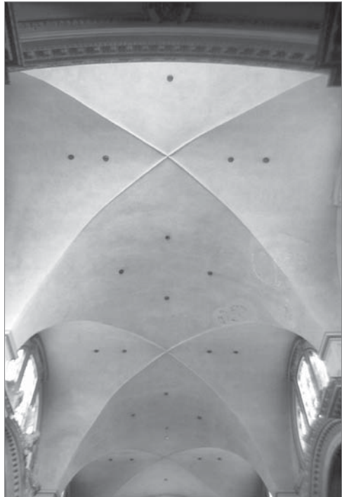
Figs. 91, 92 y 93. MERCADO DE TRAJANO (Foro Imperial de Trajano, Roma, Siglo II). Arriba. Tramos de bóvedas de arista romanas. Abajo izquierda. «arbotantes» exteriores de estriado de los empujes de las bóvedas de arista de la figura anterior, reconstruidos. Abajo derecha. SANTA MARÍA DE LOS ÁNGELES - TERMAS DE DIOCLECIANO (Roma, siglos II-XVI). Tramos de bóvedas de arista romanas, restauradas por Miguel Ángel. Ver las ventanas en los vanos laterales, abiertos ya en época romana.
