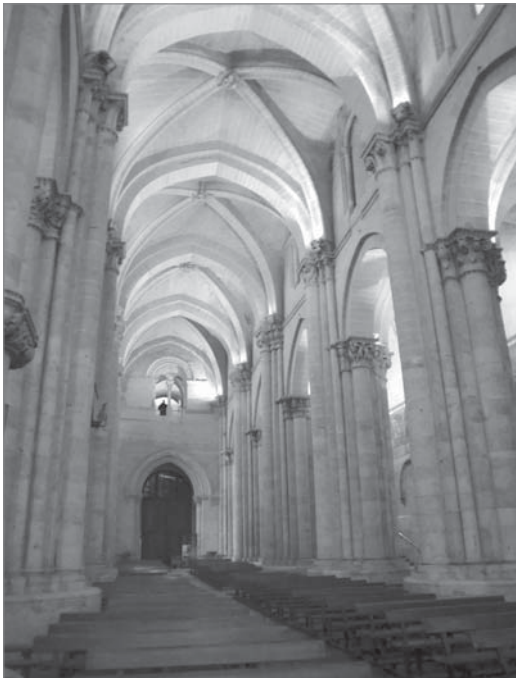
Figs. 220, 221 y 222. Arriba izquierda. SAN ISIDORO DE LEÓN (España, siglo XI). Ver la incidencia del arístón de la bóveda de la nave lateral sur. Abajo izquierda. CATEDRAL VIEJA DE SALAMANCA (España, siglo XII). Pilar cruciforme con semicolumnas en sus cuatro caras, que presenta una más en el rincón del pilar para articular el arco diagonal de la bóveda de crucería de época románica. Derecha. Planta y alzado parcial desde la nave central de un pilar cruciforme con semicolumnas en cada cara.
