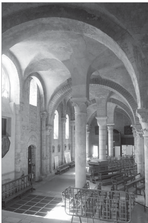
Figs. 109, 110. Arriba. SAINT HILAIRE DE POITIERS (siglos XI-XIX, Francia). Bóvedas de arista de tipología romana en su deambulatorio. Notar cómo la adaptación de estas bóvedas a la planta circular del deambulatorio ha ocasionado por la impericia de los maestros el trazado de aristas irregulares. Abajo. Tercer tramo de la lateral sur. Las bóvedas de arista de tipología romana se estriban en una columna central común, con adaptaciones irregulares. Este tramo es fundamentalmente original del siglo XI, ya que toda la parte de los pies de esta iglesia, cayó o fue radicalmente reconstruida siguiendo más o menos las pautas anteriores.
