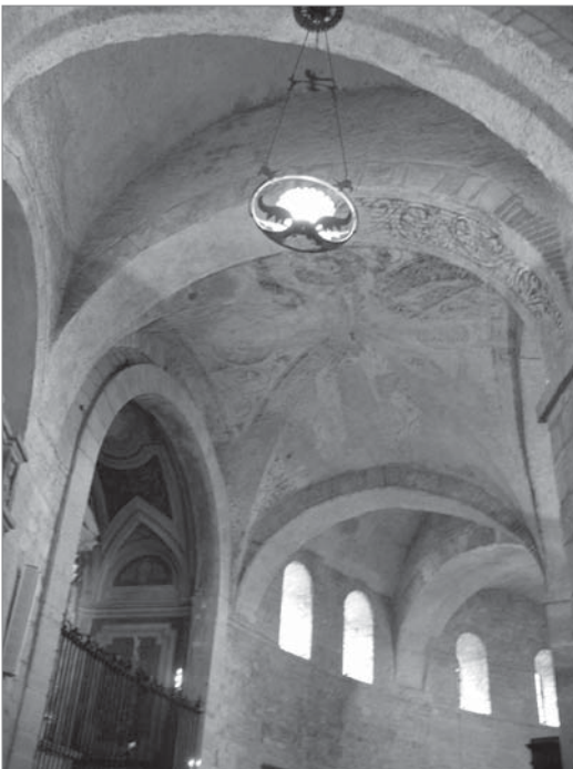
Figs. 241, 242 y 243. Arriba. CRIPTA DE SAINT BENOÎT SUR LOIRE, FLEURY (Francia, siglo XI). Bóveda de un tramo de la planta del deambulatorio con luneto curvo recayente al lado corto y luneto apuntado al exterior. Ver que este último presenta su vértice no correspondiente a la clave de la bóveda, pero que los lados de ambos lunetos, bien que sin contacto alguno, se alinean. Centro. Croquis de plantas cenitales de bóvedas de arista sobre tramos trapezoidales de un deambulatorio. Abajo. LA ROTONDA DE BRESCIA (Italia, siglo XI). Ver cómo la regularización de los tramos del deambulatorio exterior a tramos cuadrados, implica la disposición de tramos triangulares cubiertos por bóvedas de geometría compleja que se adaptan a ellos.
