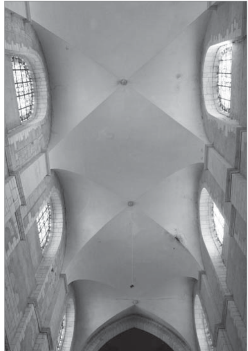
Figs. 106, 107 y 108. Arriba izquierda. GEOMETRÍA DE LA BÓVEDA DE ARISTA ROMÁNICA. Croquis de la planta y sección transversal de una bóveda de arista románica sobre tramo cuadrado de planta. Arriba derecha. SAN ISIDORO DE LEÓN (España, siglo XI). Nave lateral sur. Bóvedas de arista peraltadas sobre tramos con arcos de medio punto peraltados. Abajo. LA CHARITÉ SUR LOIRE. (Francia, siglos XI-XII). Nave central hacia los pies. Tramos de bóvedas de arista con sus plementos continuos, siguiendo la tradición romana. Y eso que se construyeron ya en el siglo XII.
