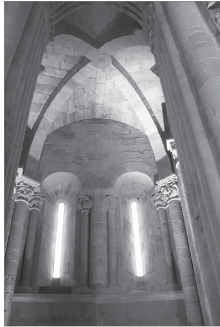
Figs. 151, 152 y 153. Arriba. SAN FRUCTUOSO DE BARÓS (Huesca, España, siglo XII). Anforillas de reverberación en el ábside. Destruídas recientemente. Ver el aparejo de la semicúpula del ábside. Abajo izquierda. CASTILLO DE LOARRE (Huesca, España, siglo XI-XII). Cabecera de la Iglesia de San Pedro. Ver como la existencia de una cripta, que presenta sus ventanas abiertas en la parte inferior y la situación de la cabecera de la iglesia, obligó a la construcción de contrafuertes articulados en sus muros, que se elevan desde su cripta. Ver la articulación de las ventanas. Abajo derecha. SANTO DOMINGO DE LA CALZADA (La Rioja, España, siglo XI). Bóveda de crucería con arcos diagonales de sección recta cubriendo un absidiolo recto de planta sensiblemente cuadrada.
