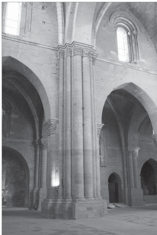
Figs. 223, 224 y 225. Arriba. CATEDRAL DE LÉRIDA (España, siglo XII). Un pilar compuesto con múltiples semicolumnas que amortiguan el impacto de su potencia. Esta es ya una iglesia de transición hacia el gótico. Abajo izquierda. SANT'AMBROGIO DE MILAN (Italia, siglos XI-XII). Ver el pilar compuesto con una semicolumna de ángulo recogiendo el arco diagonal de la bóveda de crucería. En una de sus primeras utilizaciones, hacia 1080. Abajo derecha. SANTA MARÍA DEL AZOQUE (Benavente, España, siglo XII). Pilar toral noroeste del crucero.
