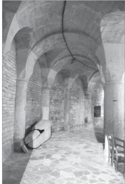
Figs. 94, 95 y 96. Arriba. BASÍLICA DE MAJENCIO-CONSTANTINO (Foro Republicano, Roma, siglo IV). Ver los sistemas de contrafuertes-arquitos aún conservados, dispuestos para estribar las potentes bóvedas de arista de argamasa y arcos de ladrillo embutido que existieron en la nave central. Abajo izquierda. BODEGA DEL ACTUAL MUSEO DE SAINT BENIGNE DE DIJÓN (Francia, inicios del siglo XI). Sus tres naves están cubiertas por bóvedas de arista continuas de tipología romana, sin arcos. Nave central. Abajo derecha. ROTONDA DE GUILLERMO DE VOLPIANO. SAINT BENIGNE DE DIJÓN (Francia, siglo XI). Sólo nos llega una pequeña parte de la gran cripta y la primera planta de las tres que tuvo la rotonda. Deambulatorio exterior. Ver cómo se cubre con tramos alternados de bóveda de medio cañón con lunetos y bóveda de arista románica de tipología romana, con arcos fajones. Estos arcos son de tipología lombarda y además empotran sus arranques en la bóveda.
