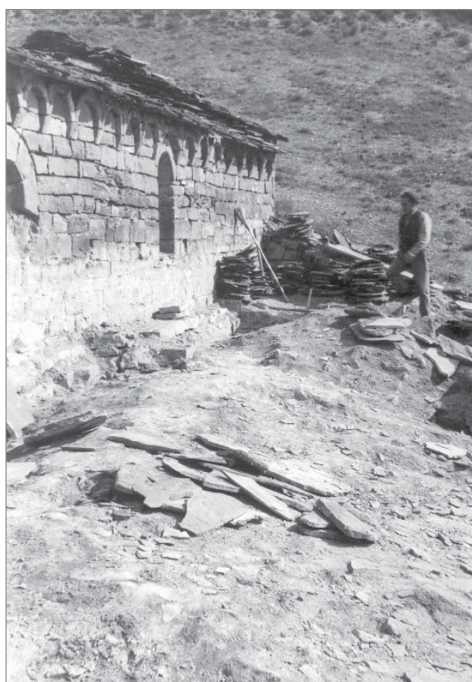
Figs. 159 y 160. ABACIAL DE SANTA MARÍA DE OBARRA (Huesca, primer tercio del siglo XI). Arriba. Cabecera. Abajo. Vista del trasdós del conjunto de las bóvedas de arista que cubren su nave sur con las capas de compresión de argamasa, durante las obras de reconstrucción de 1960-1970.
