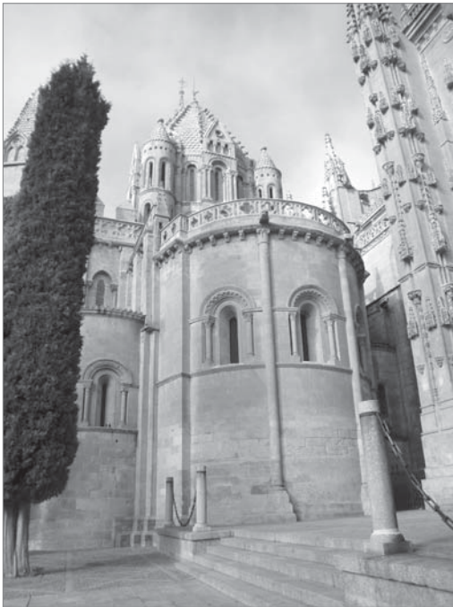
Figs. 195, 196 y 197. Arriba. CATEDRAL DE SANTIAGO DE COMPOSTELA (siglo XI). Faldones reconstruidos sobre la cubierta de la nave central, que aparecieron al retirar los de teja. Son de losas de piedra. Vista hacia los pies de la catedral. Abajo izquierda. CIMBORRIO DE LA CATEDRAL DE SALAMANCA (España, siglo XII). Ver cómo la cúpula y los torreoncitos están cubiertos con tejas de piedra de castañuela. Abajo derecha. CUBIERTA DE LA COCINA DE FONTEVRAUD (Francia, siglo XII). Ver el detalle de las piezas piramidales de piedra que la cubren y su disposición aparejada.
