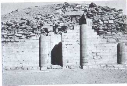
8. Sakkara. Edificio administrativo del Bajo Egipto
