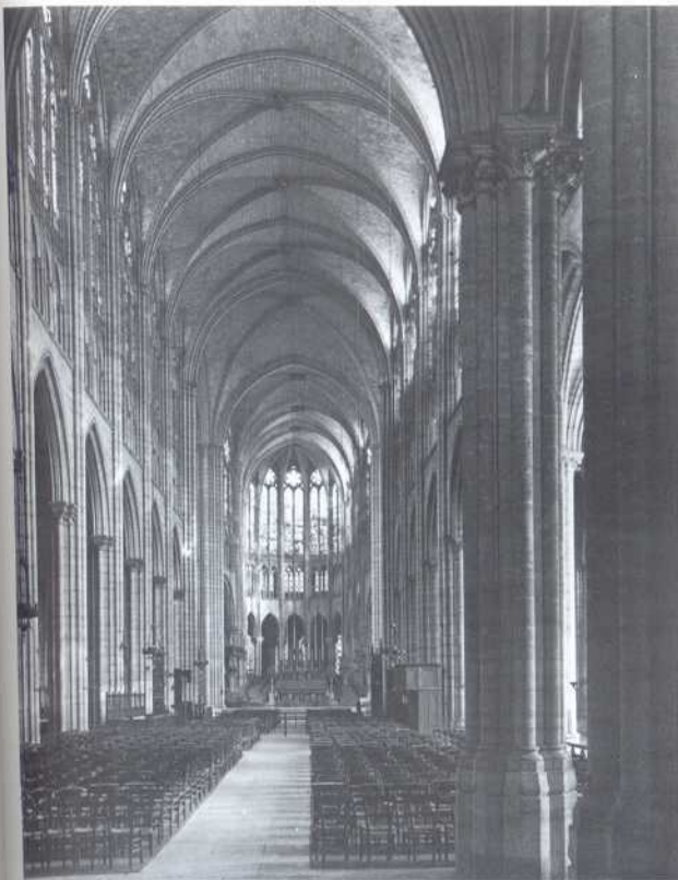
196. Chartres. Catedral. Nave central 197. St. Denis. Iglesia abacial. Nave central
