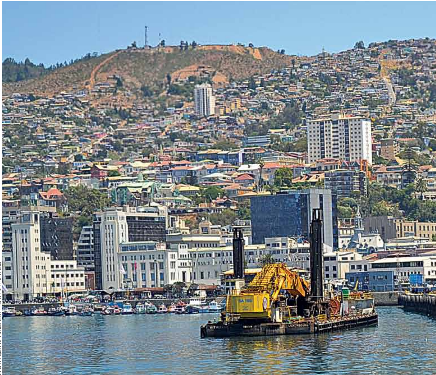
Obras de dragado con el buque draga Vitrubius ©ARKA/D. Carabias
