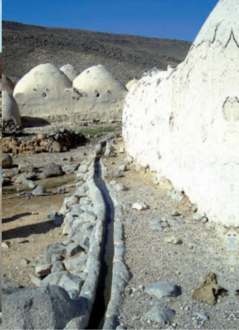
64. Canal exterior del qanat en Shallaleh Saghireh , Siria ©Hélène Gille
